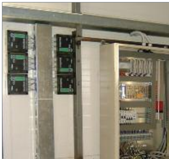
石油罐料位仪
