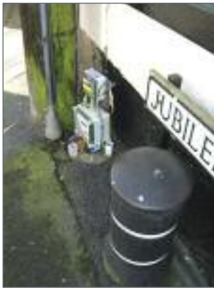
系船柱内部电池组上安装的液位 CSO
